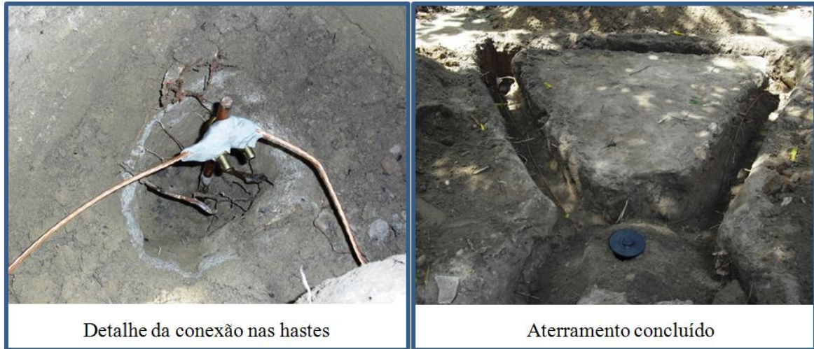
Figura C.1 - Fotos da execução do aterramento
