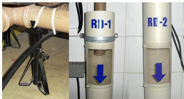
Figura 3.18 - Detalhe da fixação das tubulações e visores
