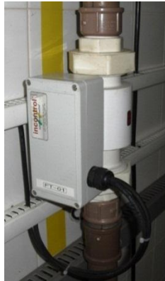
Figura 3.6 - Transdutor de vazão eletromagnético de PVC
