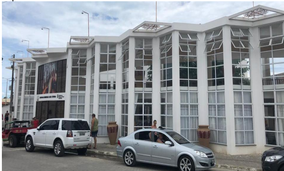
Figura 7: Fachada do Centro das Rendeiras Luiza Távora, Prainha, Aquiraz – CE.
