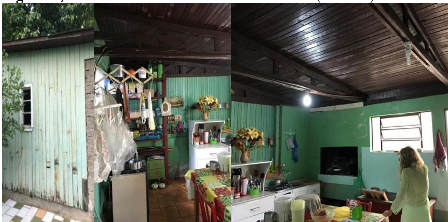
Figura 21, 22 e 23 – Vista externa e interna da cozinha (Bloco 03)
