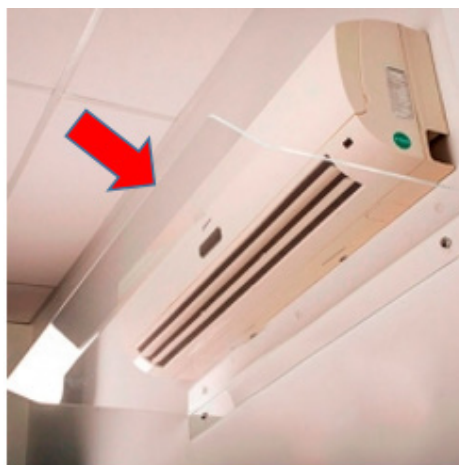
Figura 4. Defletor em acrílico para direcionar o ar em equipamentos do tipo Split.
