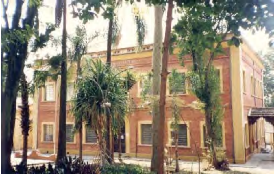
IMAGEM 6: Prédio principal do Colégio Culto à Ciência (acervo pessoal de António Carlos Ferreira Pinheiro).
