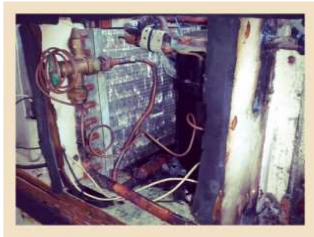
Figura C.2: Formação de gelo na válvula de expansão.
