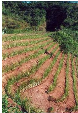
Figura 13 - Sistema Vetiver em talude. Fonte: https://mejoresfotos.com (2019).
