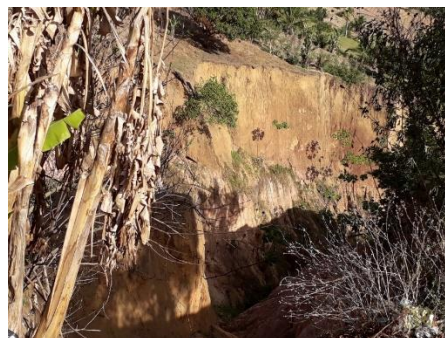
Figura 44 - Área com maior crescimento entre 2005 e 2017 da erosão. Fonte: Registro feito pelo autor (2019)
