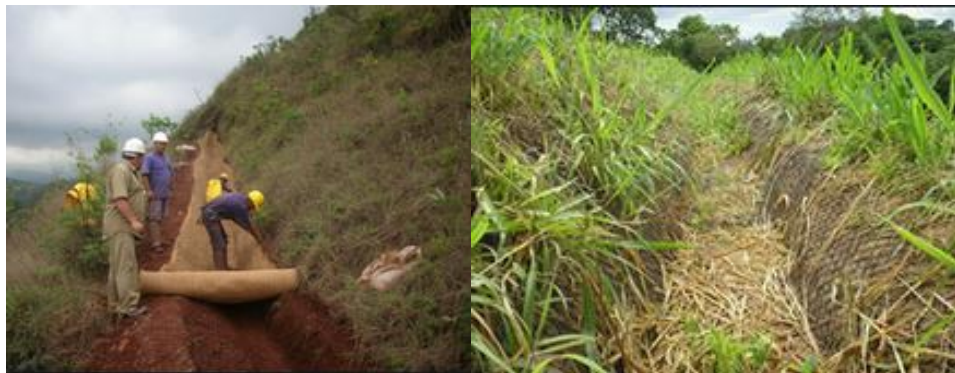
Figura 62 - Instalação de tela sintemax. Fonte: Deflor Bioengenharia (2019).
