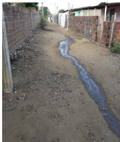
Figura 24 - Falta de esgotamento sanitário nas residências do entorno. Fonte: Registro feito pelo autor (2019)
