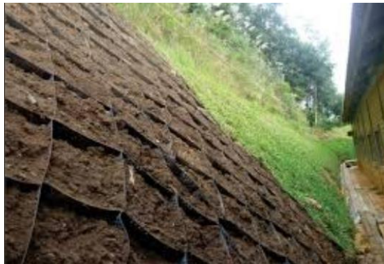
Figura 5 - Utilização de cobertura vegetal em associação com geocélula. Fonte: http://www.diprotecgeo.com.br (2019)
