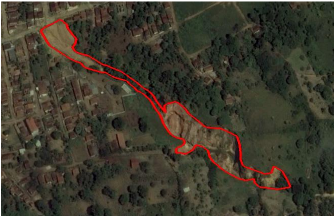
Figura 40 - Erosão no ano de 2016. Fonte: Google Earth. Modificado pelo autor (2019)
