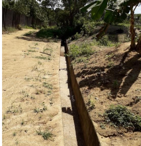
Figura 29 - Canal de drenagem em rua paralela à erosão. Fonte: Registro feito pelo autor (2019).
