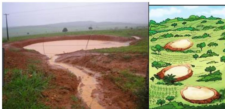
Figura 63 - Pequenas barragens para água interceptada pelas canaletas. Fonte: Deflor Bioengenharia (2019).
