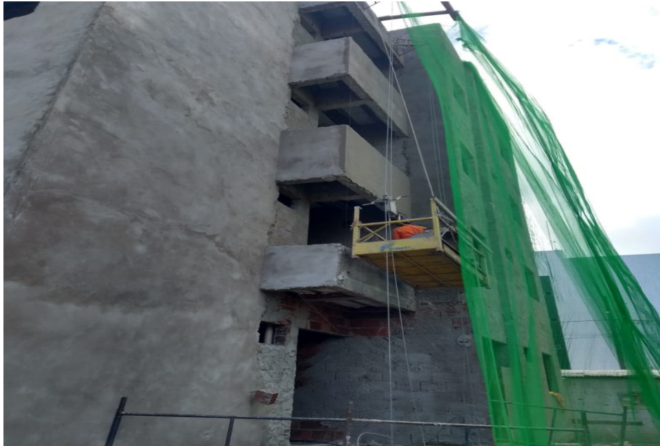
Figura 12: Execução de emboço externo.
