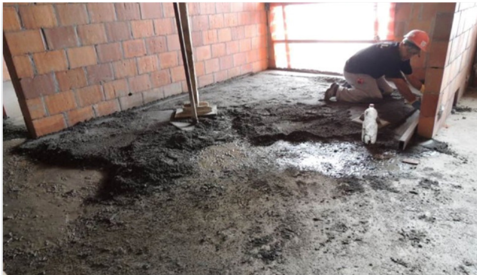
Figura 13: execução de serviço de contrapiso
