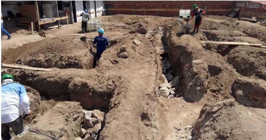
Figura 10: Enrocamento com pedra argamassada.
