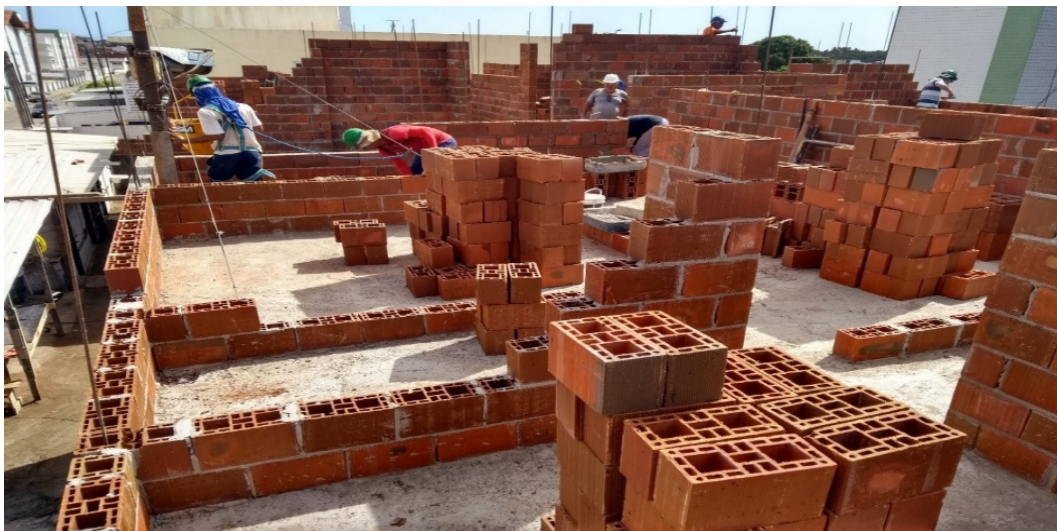
Figura 11: Execução de alvenaria estrutural.
