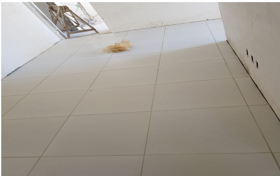
Figura 14: Revestimento cerâmico de piso.
