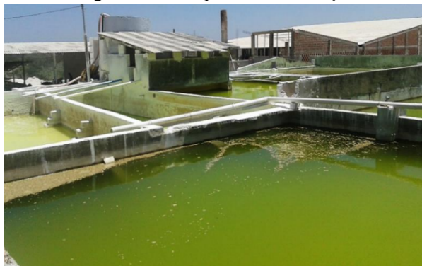
Figura 1 - Tanques de decantação
