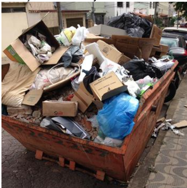
Figura 18 – Resíduos da Construção Civil misturados com outros tipos de resíduos em caçambas. Foto: Aloyso Tancredo.
