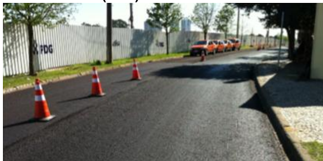
Figura 29 - Pavimentação com recapeamento em concreto asfáltico com ligante de borracha em Curitiba. Fonte: SANCHES et al. (2012)
