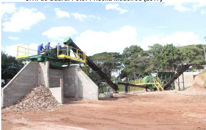
Figura 14 - Peneirador Usina Municipal de Reciclagem de Resíduos Inertes da Construção Civil de Bauru. Foto: Priscila Medeiros (2017)
