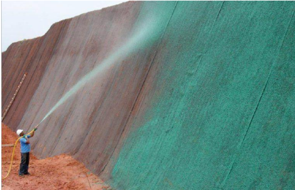
Figura 27. Aplicação de hidrossemeadura em Talude coberto por Geogrelha. Fonte: GEOSYNTHETICA, 2017.
