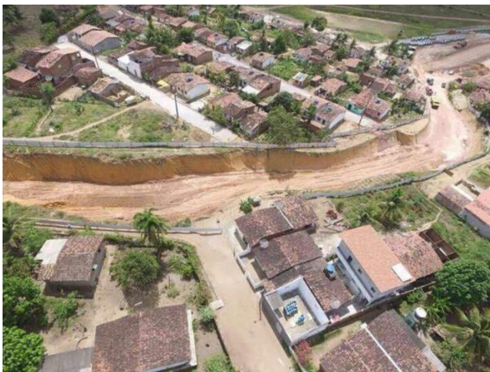
Figura 24. Utilização da Feição erosiva como arruamento. Fonte: FRANÇA (2017)
