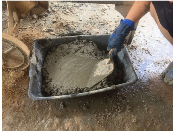
Figura 8 - Verificação de coesão e trabalhabilidade do concreto
