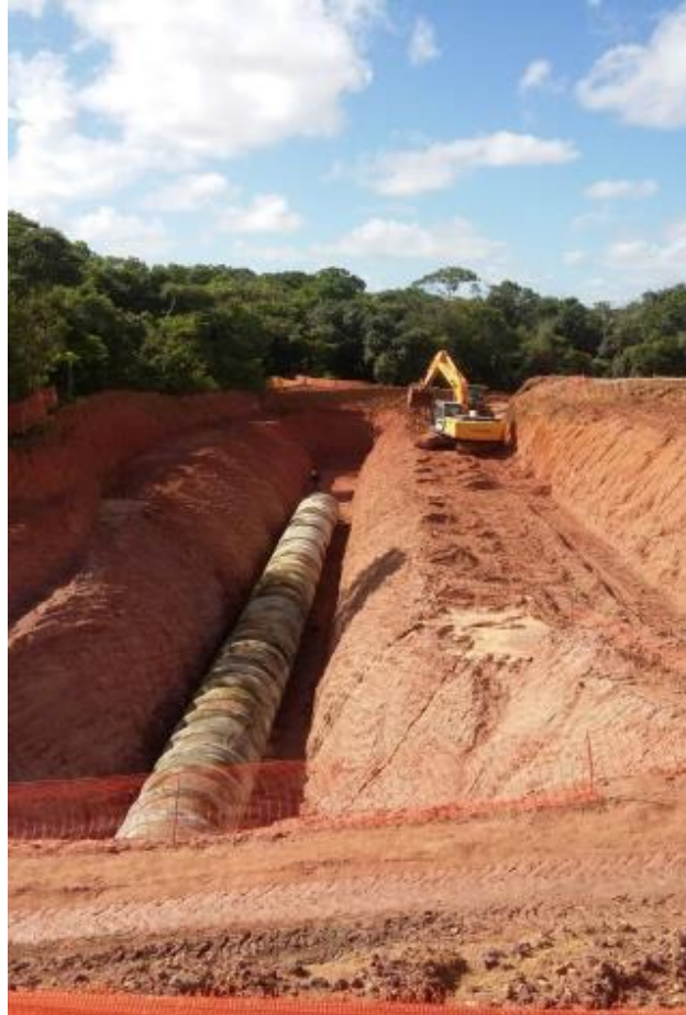
Figura 14: Execução de um trecho da rede de drenagem do empreendimento estudado.
