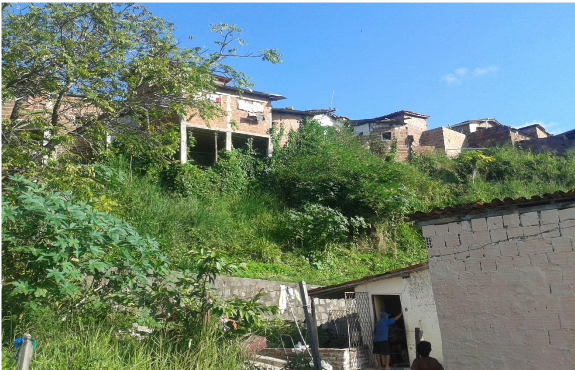
Figura 19 – Alta pressão sobre o muro de arrimo
