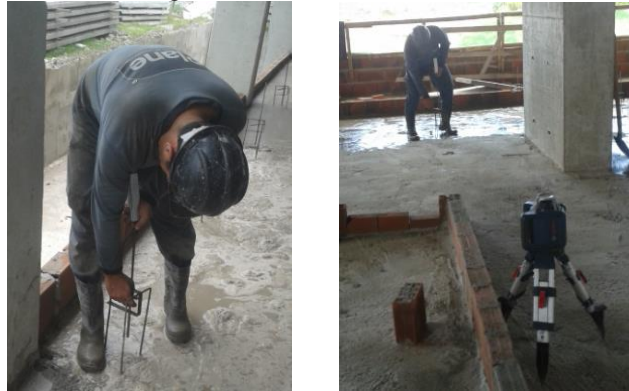
Figura 15 – Nivelamento a laser.
