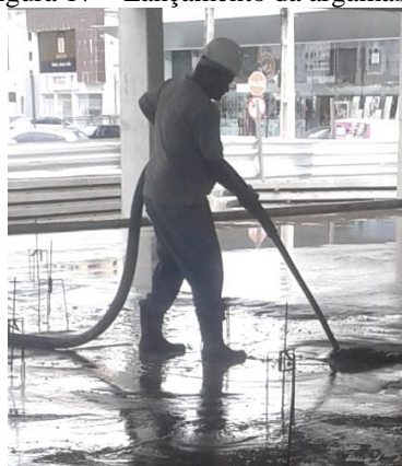
Figura 17 – Lançamento da argamassa.
