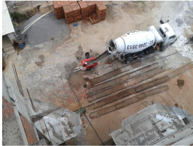
Figura 10 – Lançamento de argamassa autonivelante para um pavimento.
