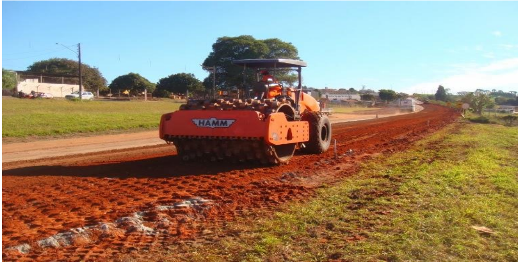
Figura 2.3: Compactação com rolo pé-de-carneiro Fonte: Autor.
