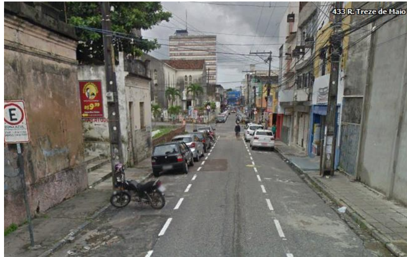
Figura 10 – Exemplo de via com dimensão de calçada insuficiente – região 1.
