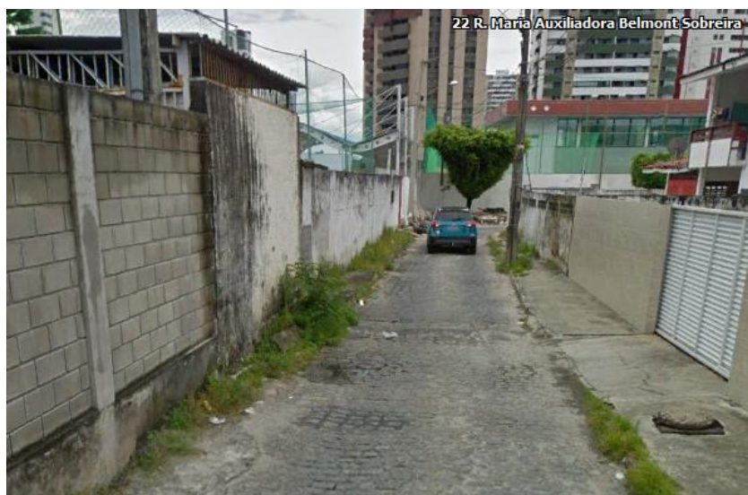
Figura 11 – Exemplo de via com dimensão de calçada insuficiente – região 2.
