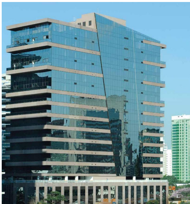
Figura 2 — Edifício The One Faria Lima
