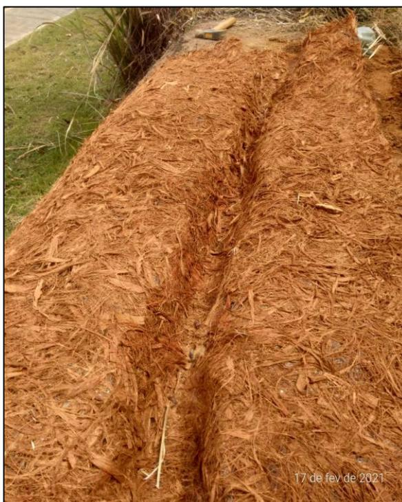
Figura 50. Fixação da valeta por meio dos grampos. Fonte: Autor próprio
