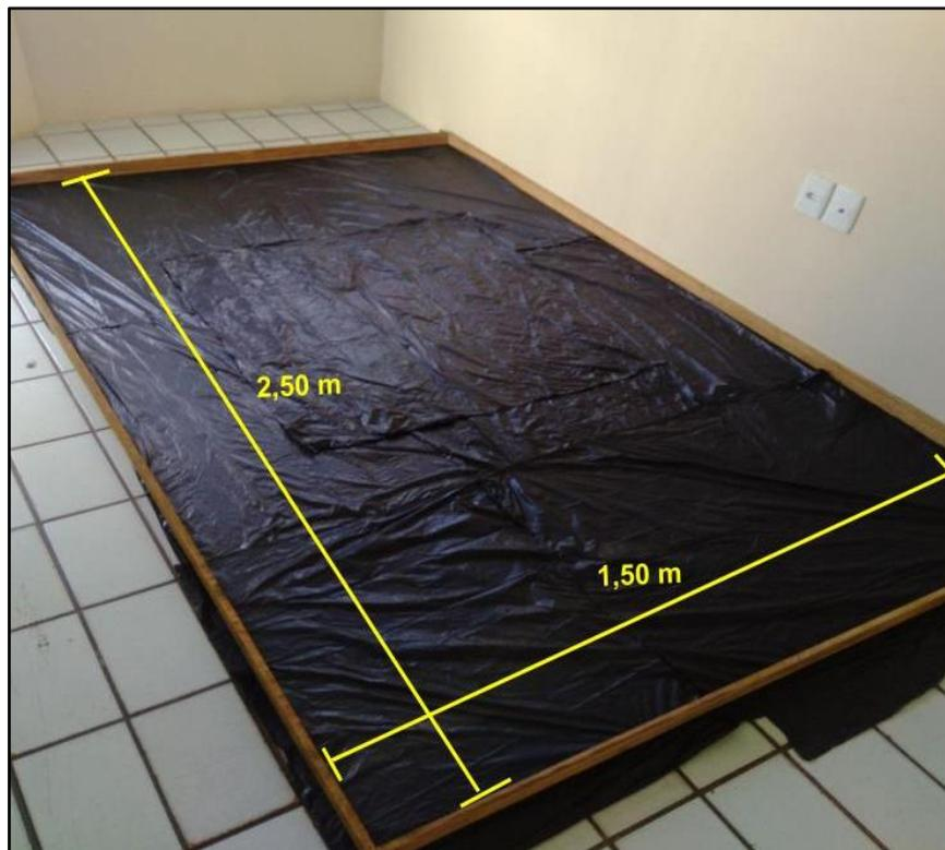
Figura 31. Construção da forma. Fonte: Autor próprio
