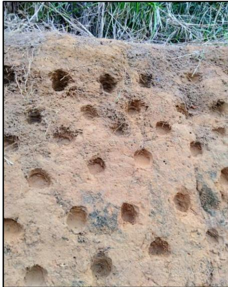
Figura 42. Detalhamento das micro-covas no talude. Fonte: Autor próprio
