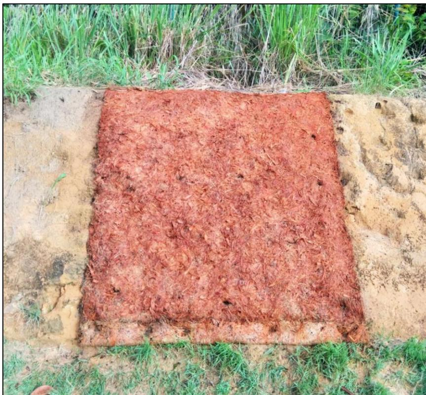
Figura 57. Biomanta instalada no talude. Fonte: Autor próprio
