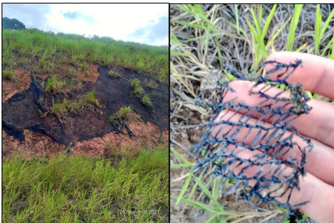
Figura 65. Detalhes da tela utilizada como solução para os taludes. Fonte: Autor próprio
