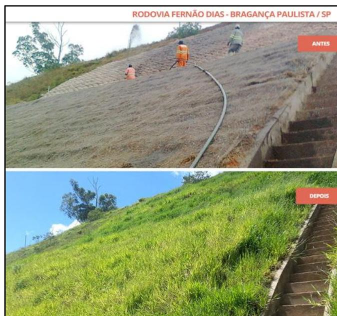
Figura 18. Exemplo de uma aplicação da hidrossemeadura antes e depois. Fonte: iguiecolgia.com
