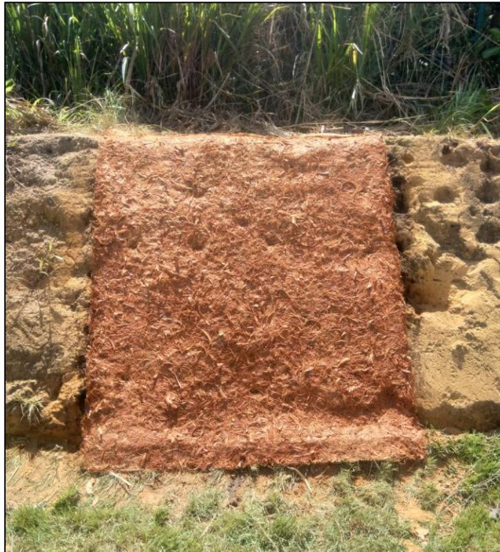
Figura 55. Fixação da biomanta na superfície do talude. Fonte: Autor próprio
