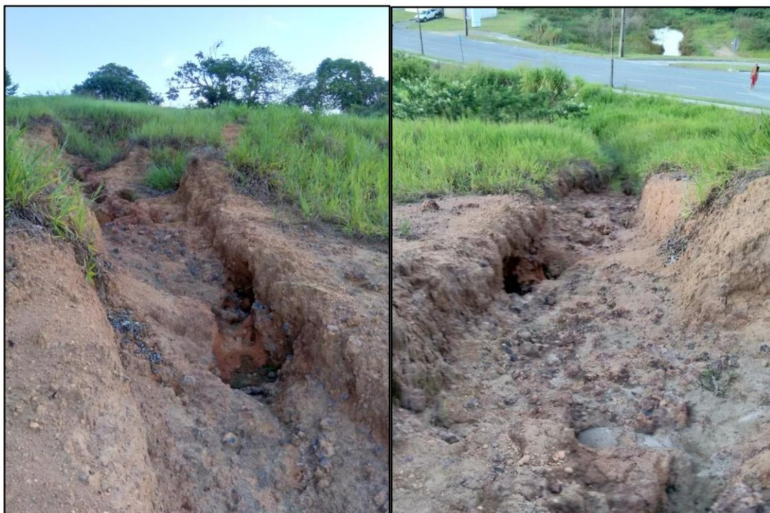
Figura 37. Detalhes da ravina encontrada no talude do acesso ao condomínio. Fonte: Autor próprio
