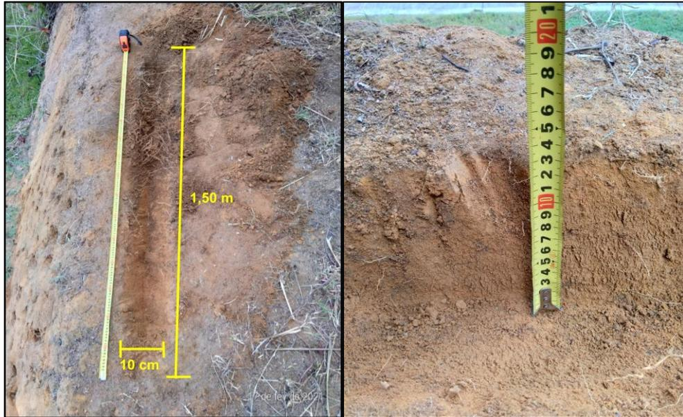
Figura 48. Escavação da valeta no topo do talude. Fonte: Autor próprio
