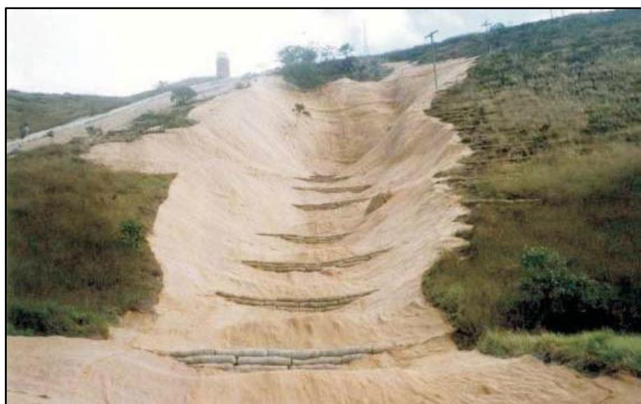
Figura 67. Retentores de sedimentos colocados no sentido transversal. Fonte: Couto et. al (2010)
