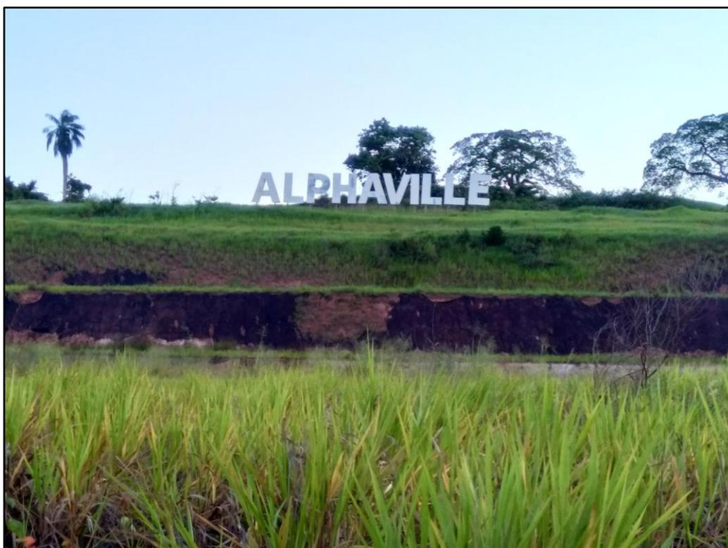
Figura 36. Falhas no recobrimento superficial no talude no acesso ao condomínio. Fonte: Autor próprio
