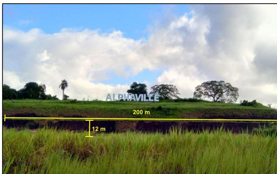
Figura 66. Medidas estimadas do talude do acesso ao condomínio. Fonte: Autor próprio
