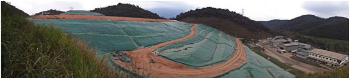
Figura 26 - Geomembrana já instalada sobre o aterro
