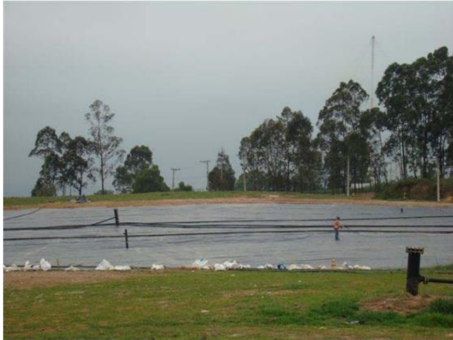
Figura 24 - Obra após instalação da geomembrana
