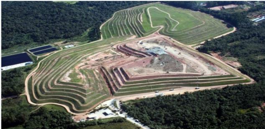
Figura 12 - Aterro sanitário de Curitiba/PR
