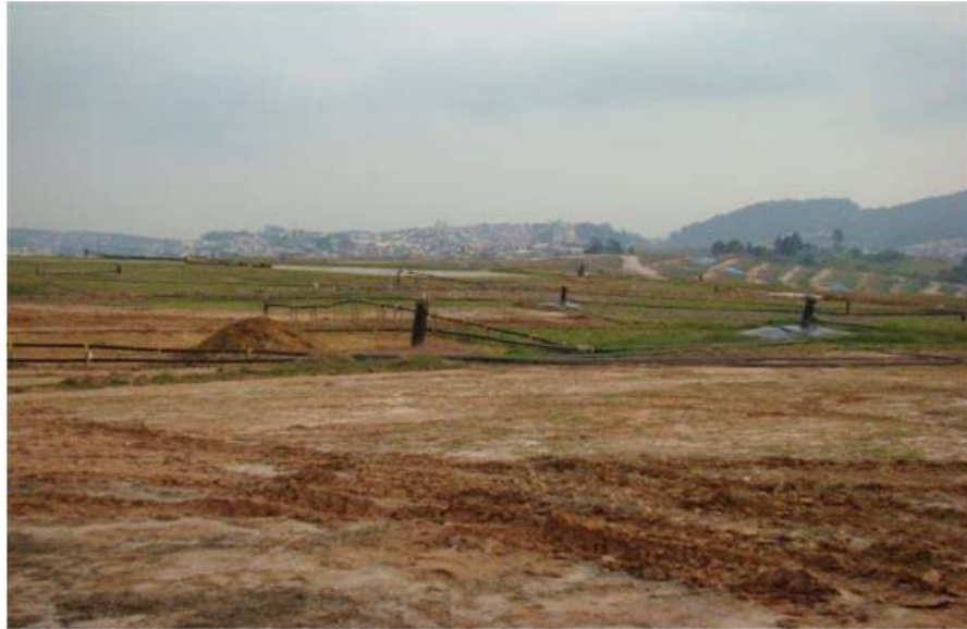
Figura 23 - Detalhe do local de instalação da geomembrana
