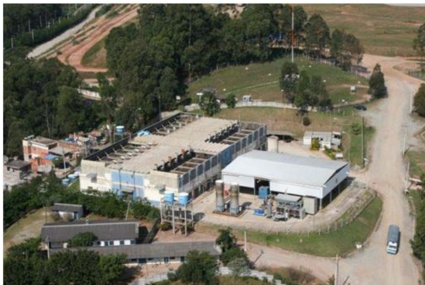
Figura 22 - Disposição dos geradores e flares
