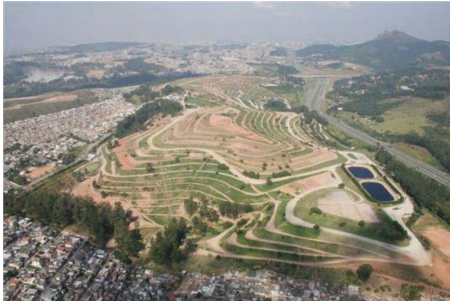
Figura 21 - Foto aérea do Aterro Bandeirantes
