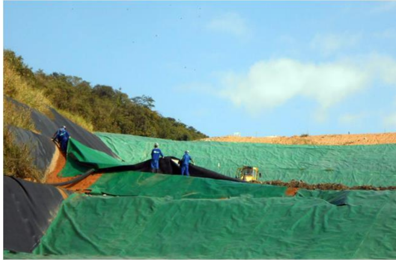
Figura 25 - Colocação da geomembrana sobre o aterro
