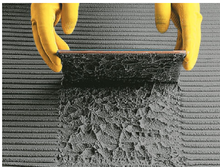
Figura 16- Teste de arrancamento para verificar preenchimento do tardez
