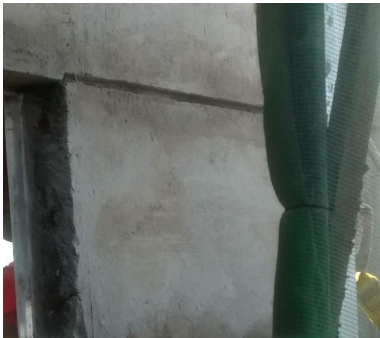
Figura 8- Emboço para revestimento cerâmico.
