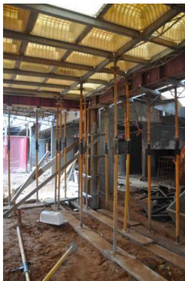
Figura 3 - Cimbramento típico de laje nervurada com cubetas
