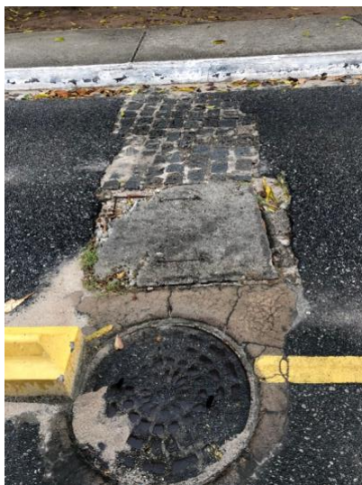
Figura 24. Remendo na Via Ipê Branco.
