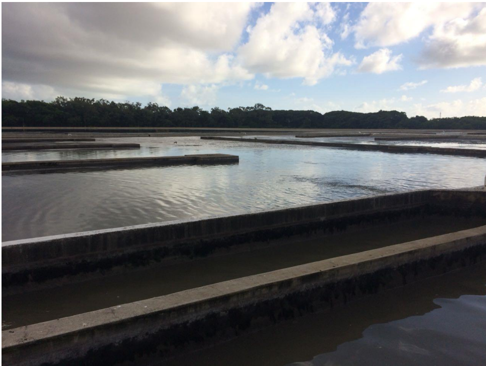
Figura 21 - Lagoa de Estabilização
