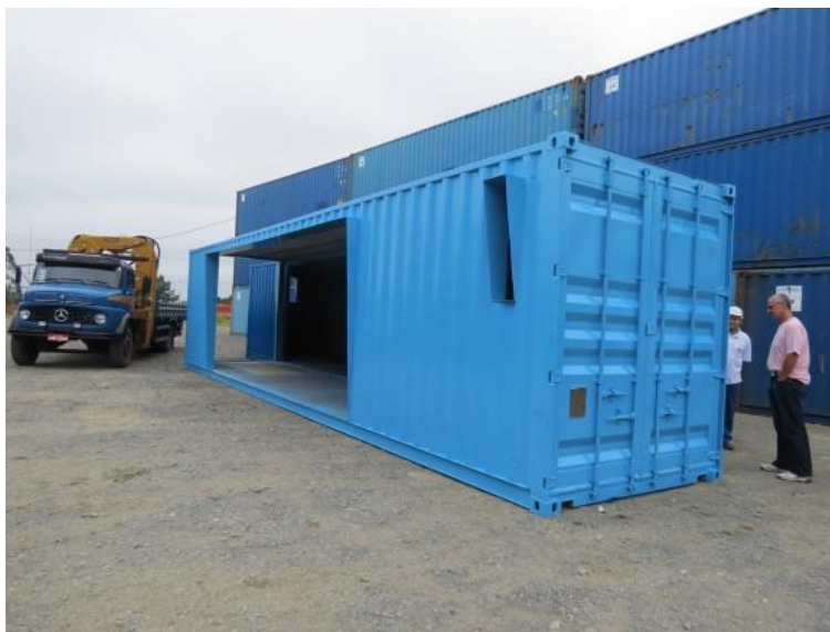
Figura 11 - Container já cortado na preparação para uso em construção civil
