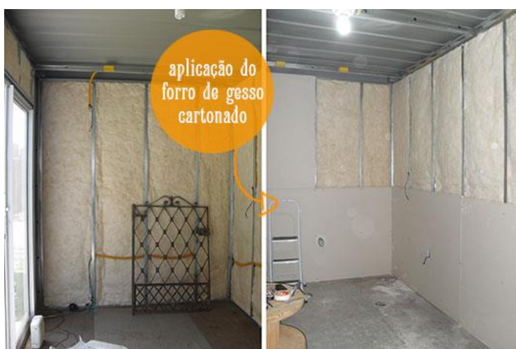
Figura 20 - Aplicação do Drywall.
