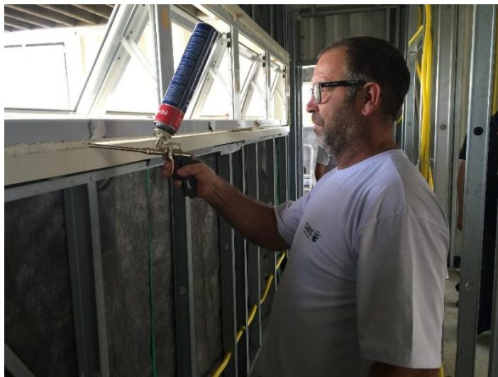
Figura 16 - Janela instalada e com a aplicação da espuma expansiva
