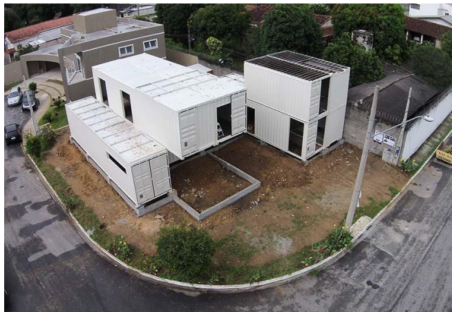
Figura 25 - Obra em andamento após locação e montagem dos containers
