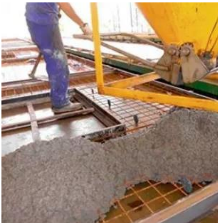
Figura 17 - Lançamento do concreto.
