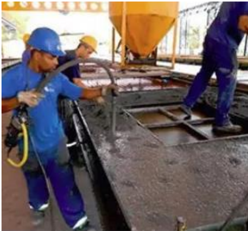
Figura 19 - Adensamento do concreto.
