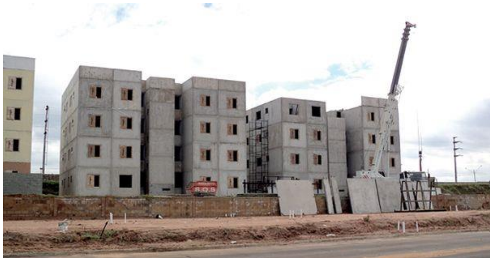
Figura 4 - Prédio em painéis estruturais.
