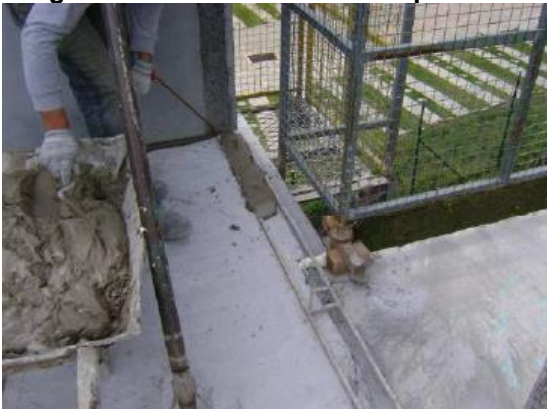
Figura 24 - Assentamento dos painéis.
