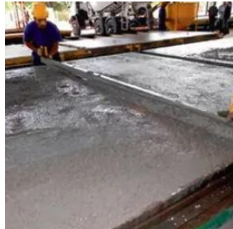
Figura 20 - Sarrafeamento do concreto.
