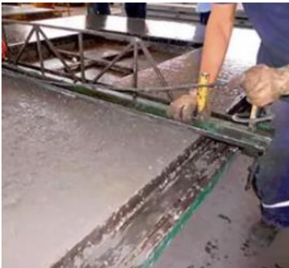
Figura 21 - Regularização com régua.
