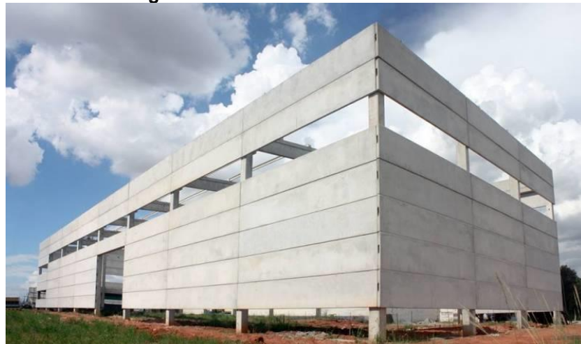
Figura 6 - Painéis de fachada.
