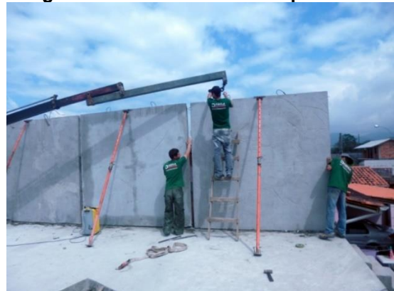
Figura 25 - Escoramento dos painéis
