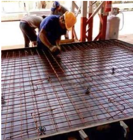
Figura 15 – Posicionamento das armaduras.
