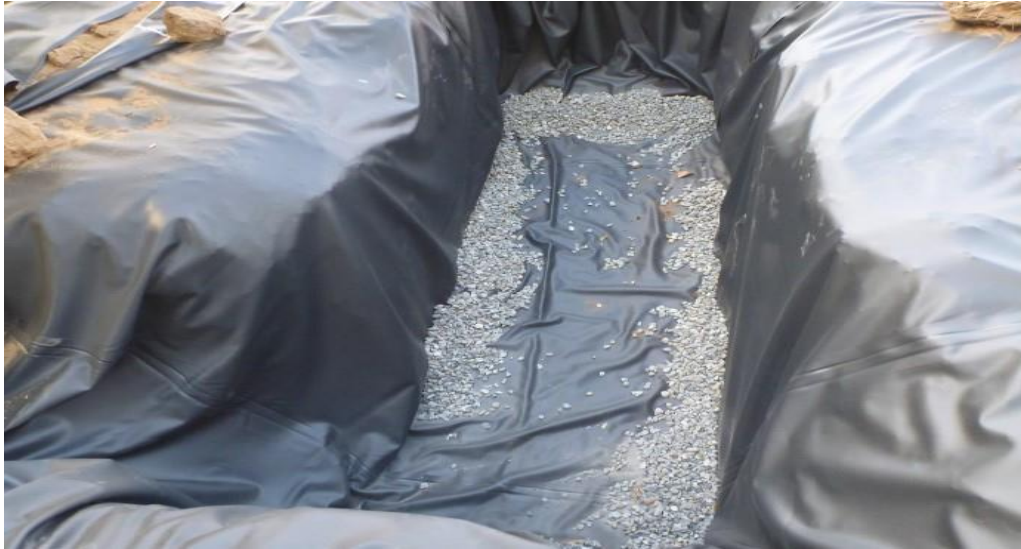
Figura 18 - forro da Wetland instalado e fixado
