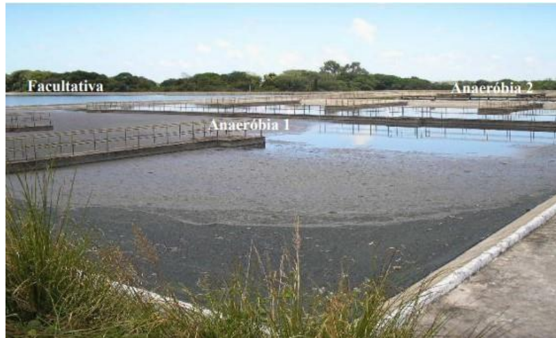
Figura 13 - Vista geral da ETE Mangabeira
