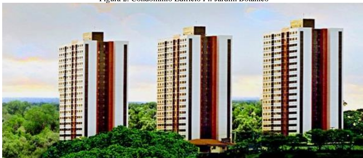
Figura 2: Condomínio Edifício Fit Jardim Botânico
