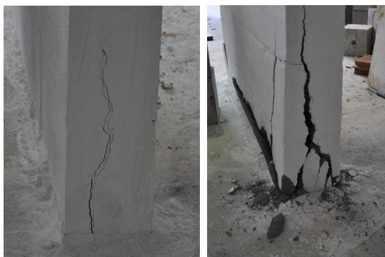
Figura 32: i - Primeiras fissuras em PBC 03, ii - Modo de ruptura da PBC 03.
