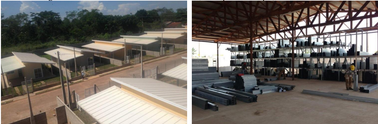
Figura 4: Condomínio residencial em Juriti-PA, i- Galpão de estoque, ii- Obra finalizada.
