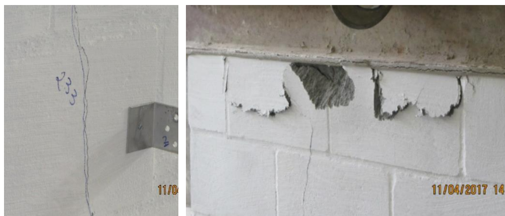
Figura 34: i - Primeiras fissuras em PBC 05, ii - Modo de ruptura da PBC 05.
