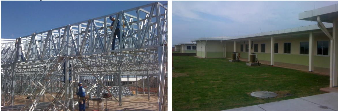
Figura 3: Prédio comercial da Petrobrás em Itaboraí, i- estrutura metálica, ii- obra finalizada.
