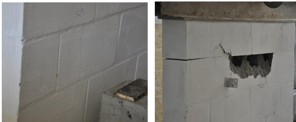
Figura 30: i - Primeira fissura na PBC 02, ii - Momento de ruptura da parede PBC 02.
