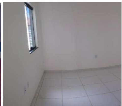
Figura 17 – Piso cerâmico do quarto.
