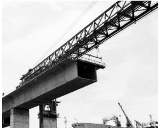
Figura 1.2 – Viga de concreto da ponte Rio-Niterói com seção transversal de paredes finas
