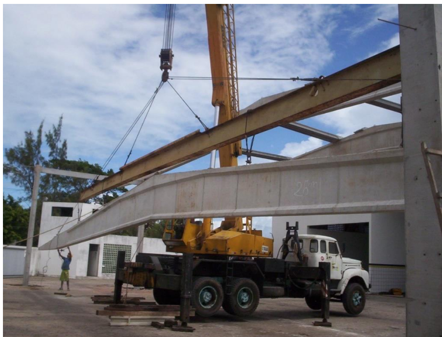
Figura 12: Viga MV2A durante içamento.
