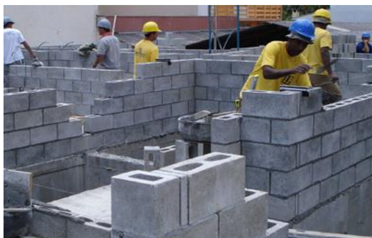
Figura 34 – Obra em alvenaria estrutural
