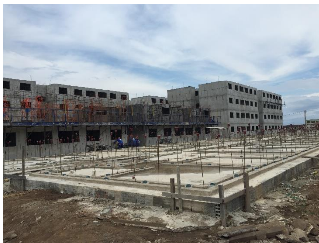
Figura 19 – Fundação tipo radier pronta para receber as telas
