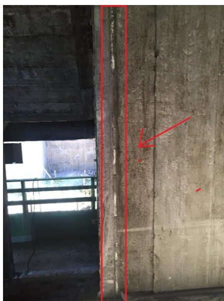
Figura 09 – Junta de dilatação
