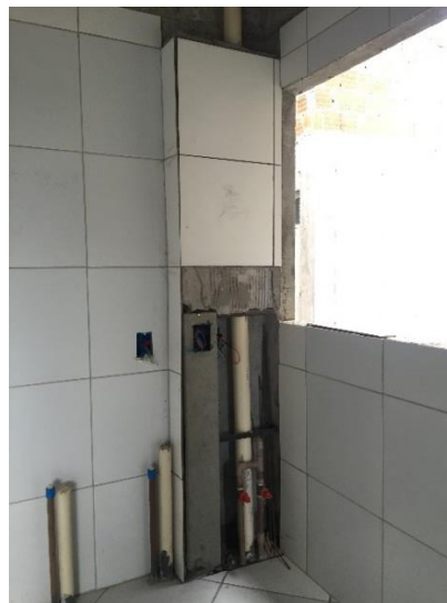
Figura 25 – Shaft em acabamento
