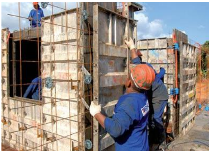
Figura 26 – Montagem das fôrmas metálicas
