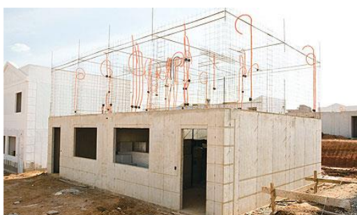
Figura 05 – Edificação pós primeira desforma
