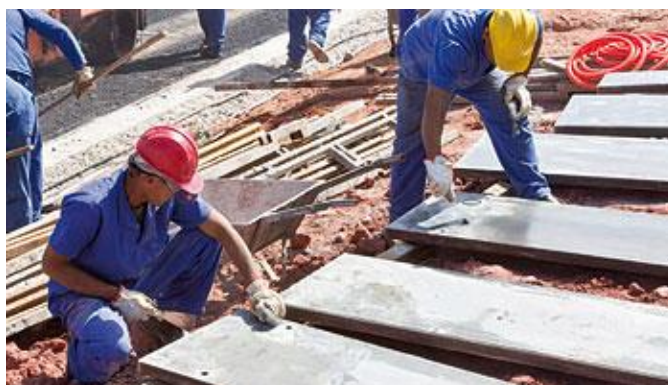
Figura 30 – Limpeza dos painéis
