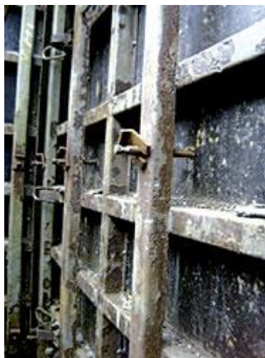
Figura 27 – Detalhe do travamento das formas
