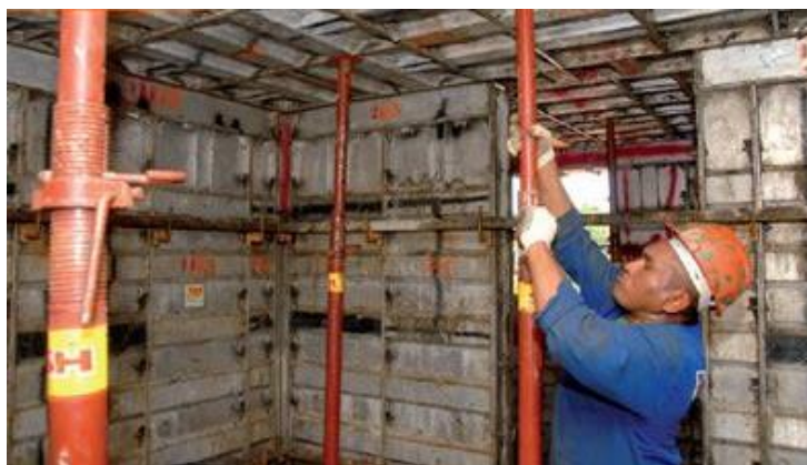
Figura 13 – Colocação das escoras
