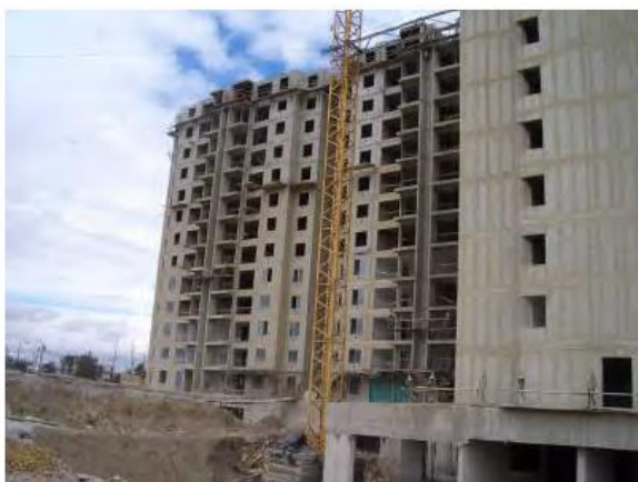
Figura 04 – Edifício em Bogotá, na Colômbia
