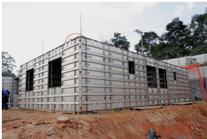
Figura 10 – Conjunto de formas metálicas
