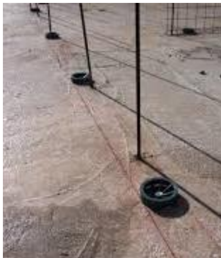
Figura 20 – Espaçadores de piso
