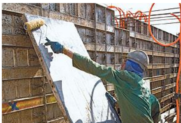
Figura 28 – Aplicação do desmoldante nas fôrmas
