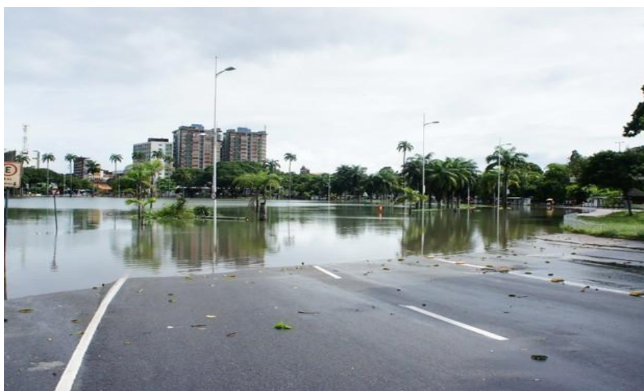
Figura 6: Alagamento do Parque Sólon de Lucena. Fonte: http://brejo.com/2012/06/28/82425/#.VzNcEJUrhF
