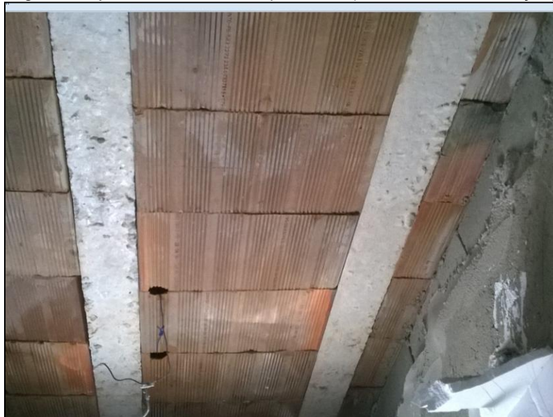
Figura 9: laje da cobertura vista por baixo (vide cinta de amarração)
