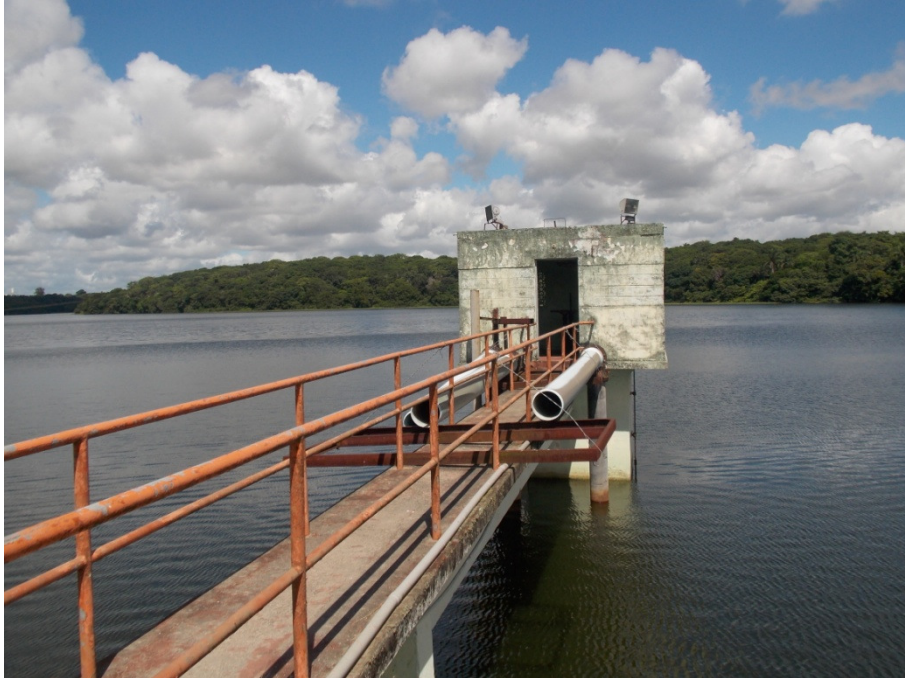
Figura 15 - Torre de Tomada - Açude Marés.
